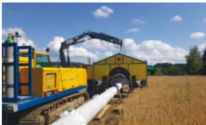
Budowa gazociągu DN300 MOP 4,0 MPa przy wykorzystaniu czołówki spawalniczej Gascontrol Polska
